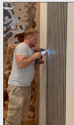
Bei der Montage ohne Kleber werden 8 bis 10 Schrauben empfohlen.
