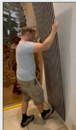
Platten auf Wand anbringen und einrichten.
